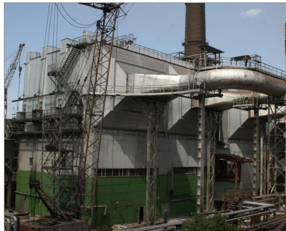
Система газоочистки из двух электрофильтров.
